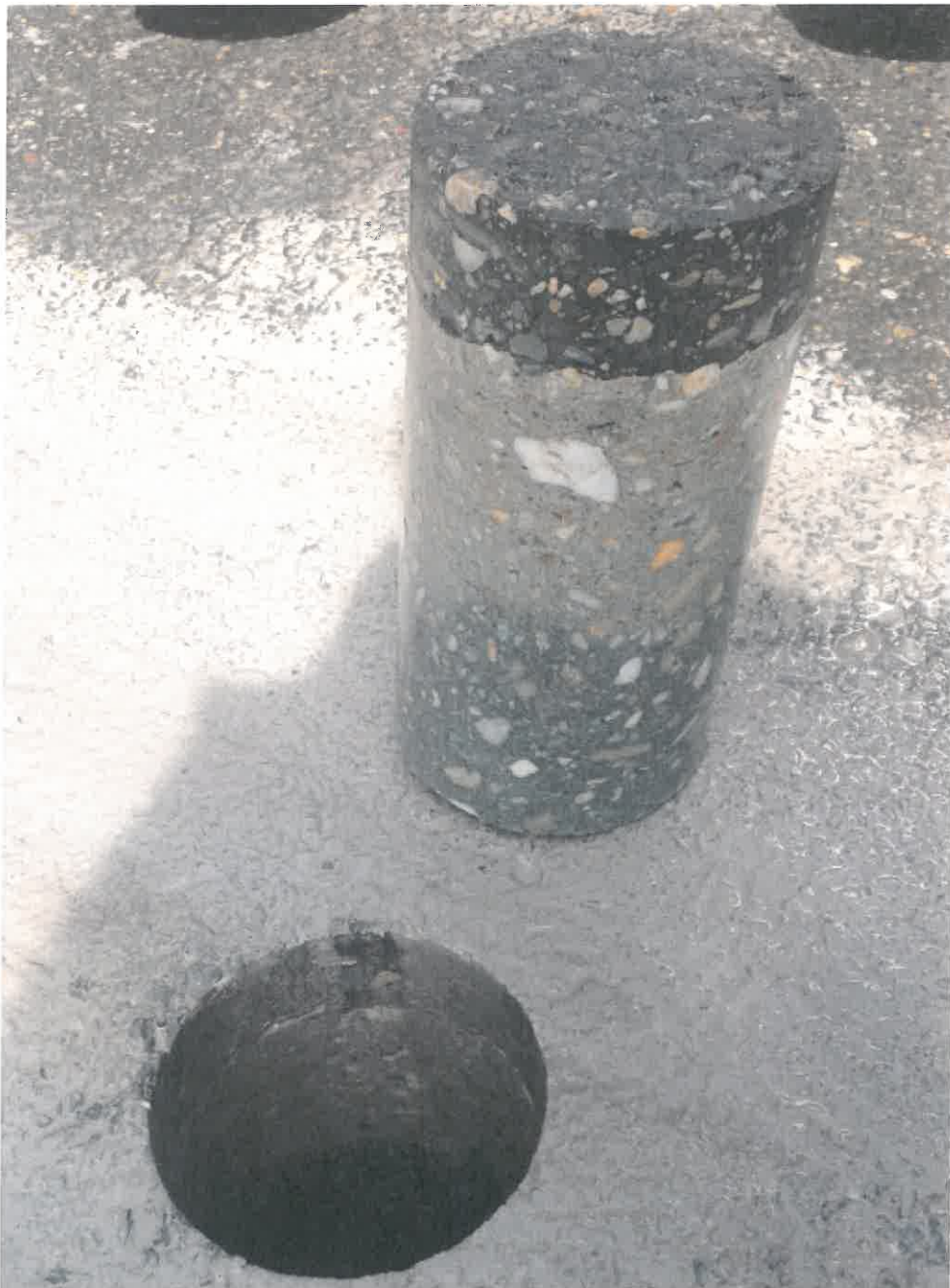
3. kép: Fúrást követően Nyíregyháza, Tó utca 0+800 km. sz. bal oldal sávközép
